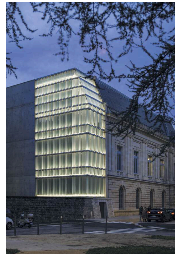
Adossé au pignon existant, le volume vertical en verre affirme une présence nocturne et recompose la silhouette du musée.
