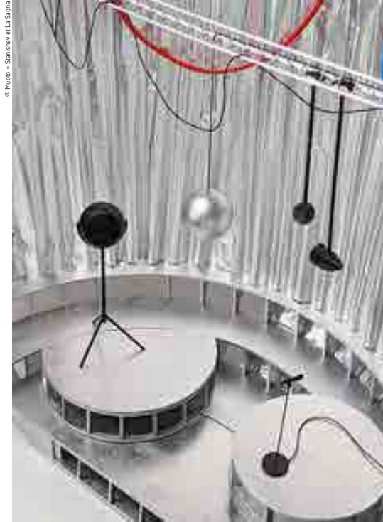
En hauteur, un pont technique est fixé au dernier parallèle pour suspendre des luminaires, des haut-parleurs et un rideau sur patience.
