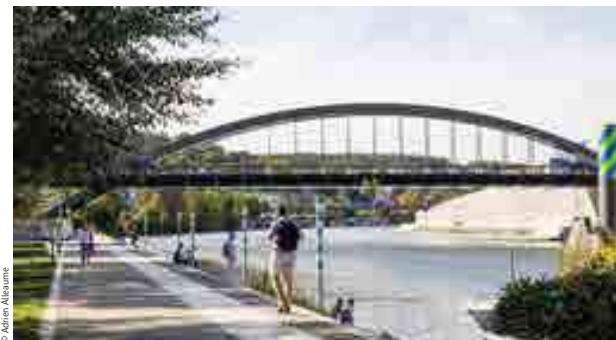
RCR et AEI - Le pont Seibert - Boulogne-Billancourt - 2023.
