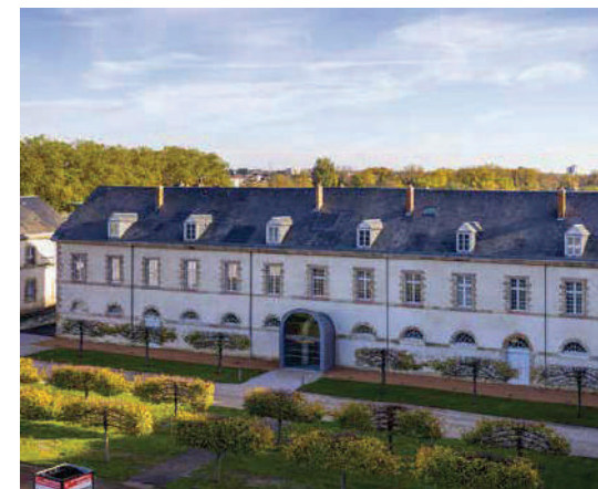
Le bâtiment réhabilité sur le site du CNCS
